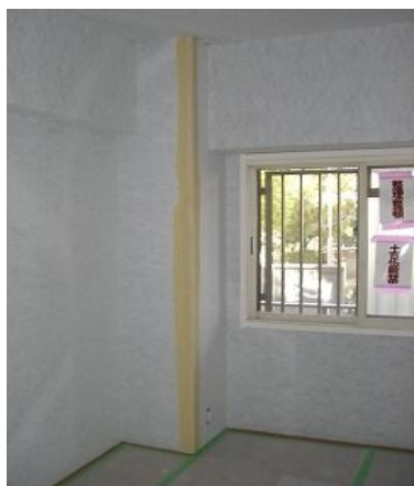
エルシート貼り完了
