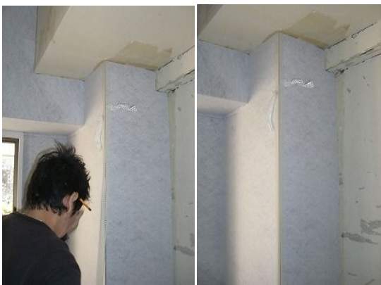
エルシート貼り状況(コーナーテープ貼り)
