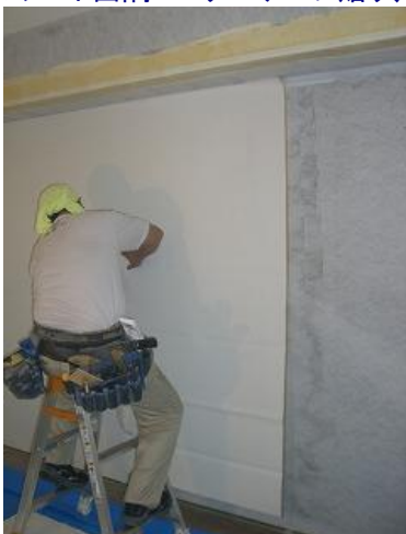
クロス貼り状況、継ぎ手部・取り合部プラゾールSS塗布
