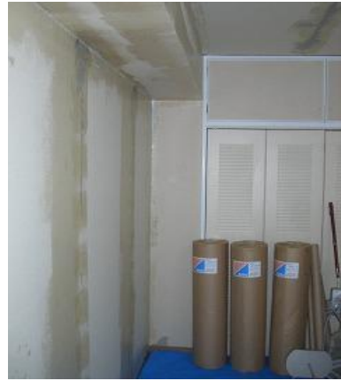
既設クロスめくり完了、下地処理状況
