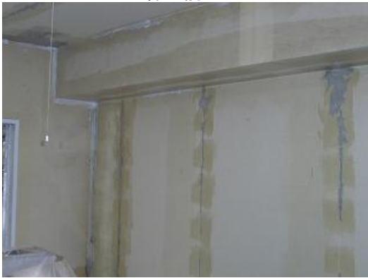
エルシート継ぎ手部・取り合部プラゾールSS塗布
