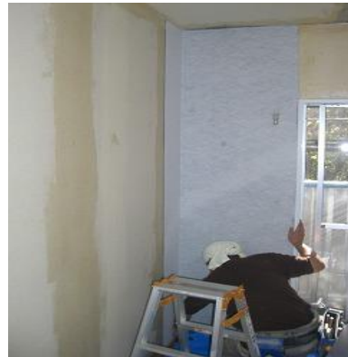
エルシート貼り状況
