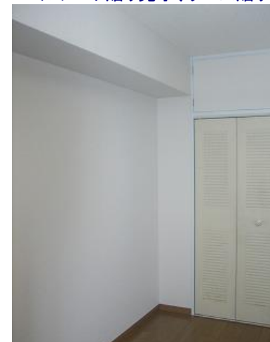
クロス貼り完了
