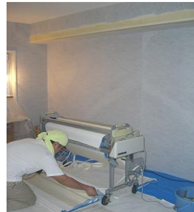
エルシート貼り完了、クロス貼り前
