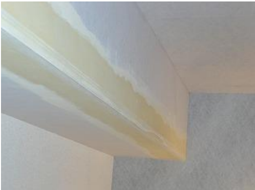
エルシート出隅コーナーテープ貼り、パテ処理
