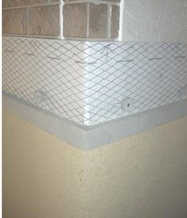
既設サイディングの外壁を塗り壁外断熱(ガイダン工法)でエコ改修
