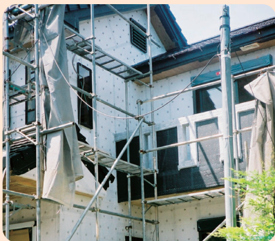
塗り壁下地完了 .....
